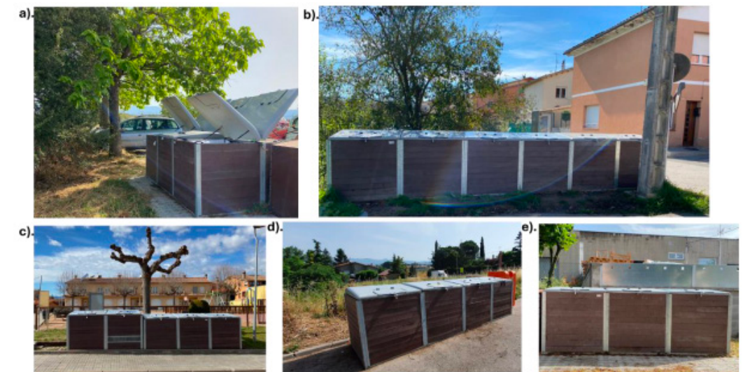
Figura 3.18. Tipos de áreas de compostaje instaladas. (a) Isla seis módulos de compostaje, (b) área en fila seis módulos de compostaje (c) área de cinco módulos de compostaje, (d) área de cuatro módulos, (e) área de tres módulos de compostaje. Adaptado de DECOST (2021)
